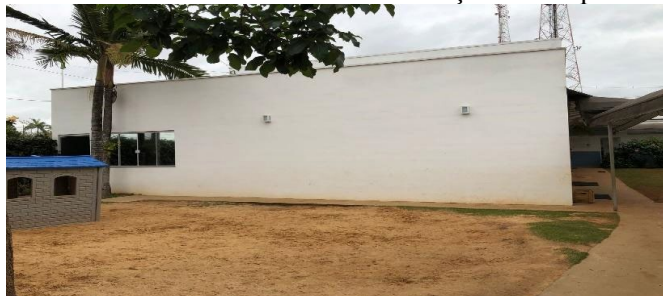
Foto 1 – Muro branco onde se dará a instalação criada pelas crianças
