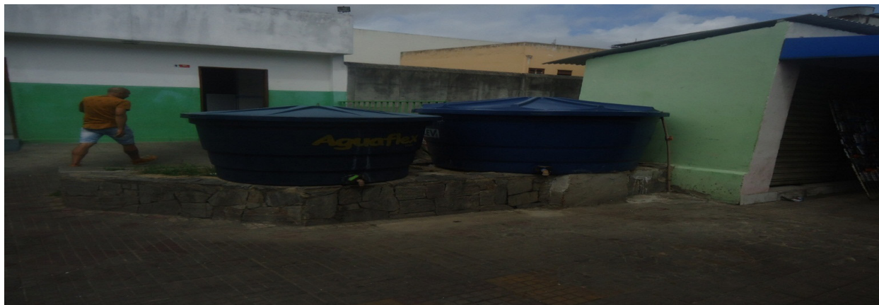
Figura 7 - Caixas para o abastecimento de água em dias de racionamento na ARCA Catedral.
